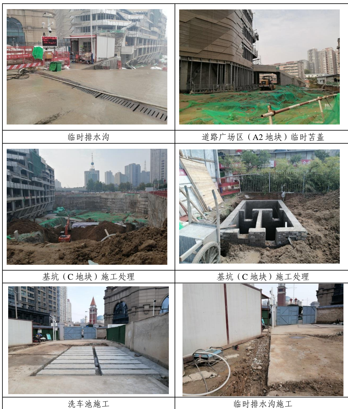
图 2-1 本季度项目区施工现状
