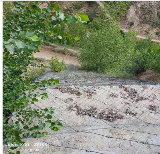
图7-3 毛石护坡水保防护措施
