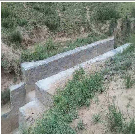
图7-2 导流堤水保防护措施
