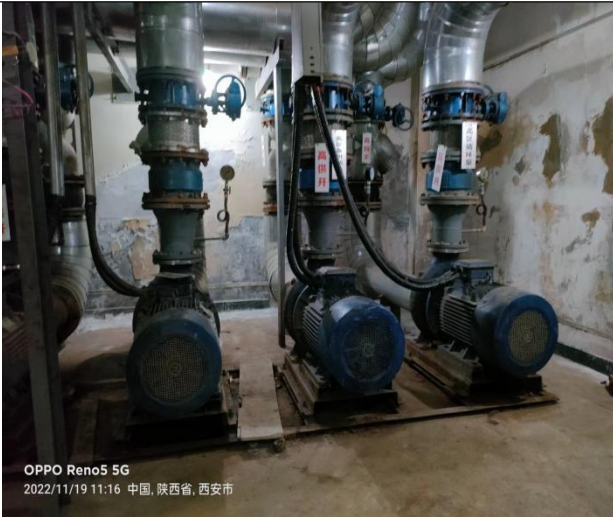
图3.9 循环泵基础减振
