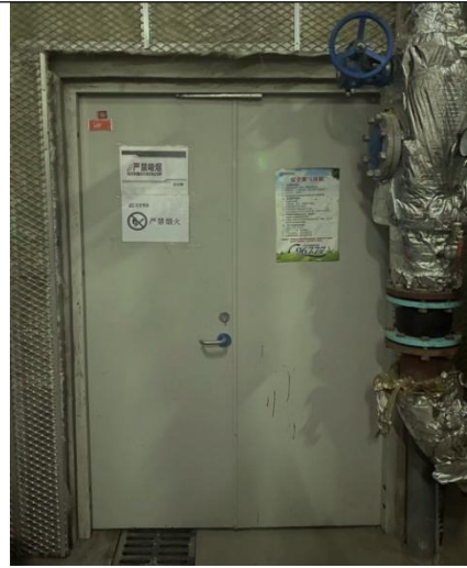
图3.10 锅炉房隔声门
