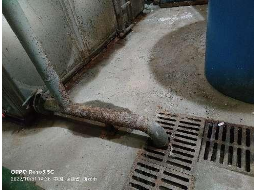
图3.5 锅炉房废水排水沟
