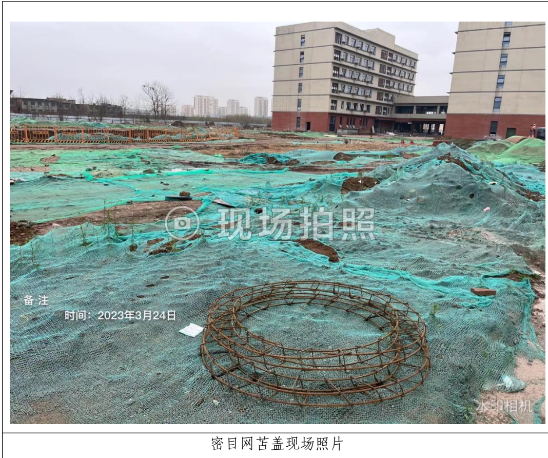
图 2-1 本季度项目区施工现状及监测情况
