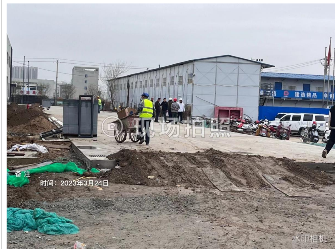
道路施工硬化
