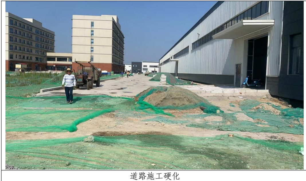
图 2-1 本季度项目区施工现状及监测情况
