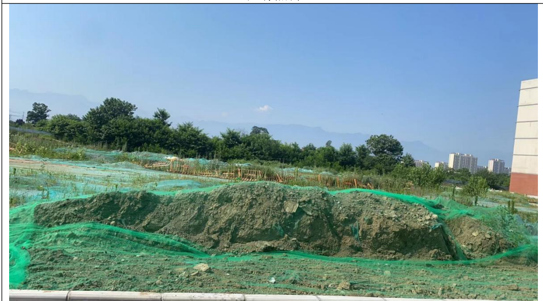
密目网苫盖现场照片
