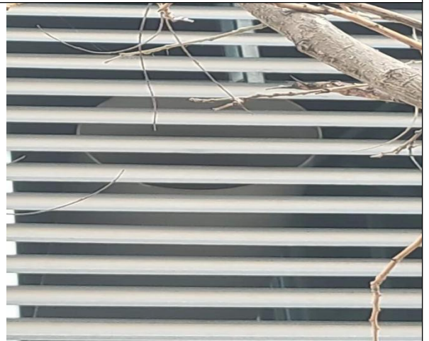
图3.4 处理后引致室外换气扇高空无组织排放形式
